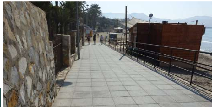
5 Rampa de acceso
