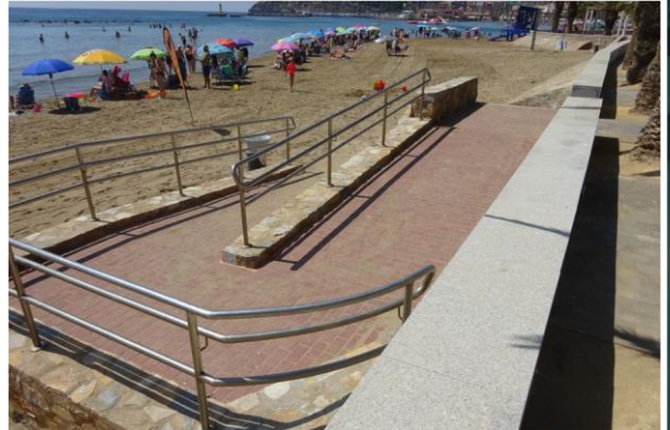
4 Rampa de acceso
