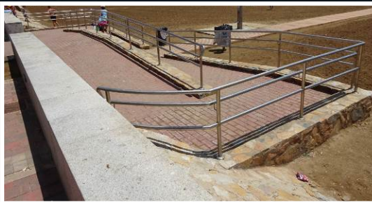
5 Rampa de acceso
