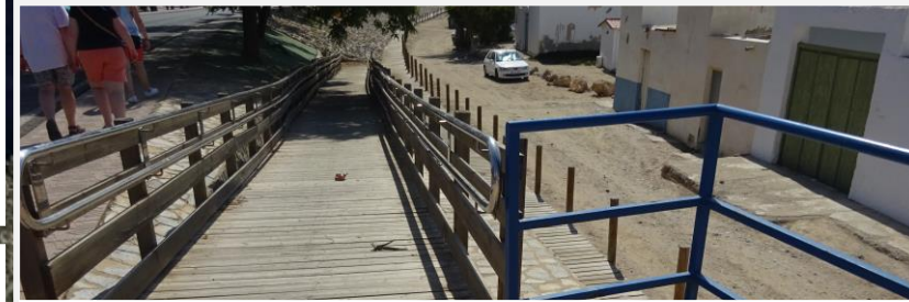
5 Rampa de acceso
