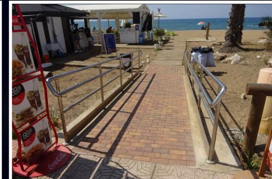
4 Rampa de acceso
