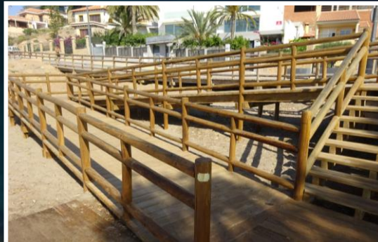
4 Rampa de acceso
