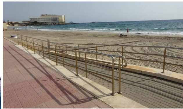
4 Rampa de acceso
