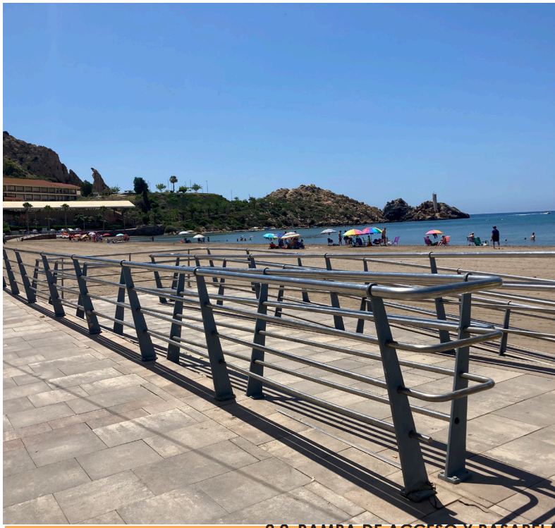
2.2_RAMPA DE ACCESO Y PASARELA
