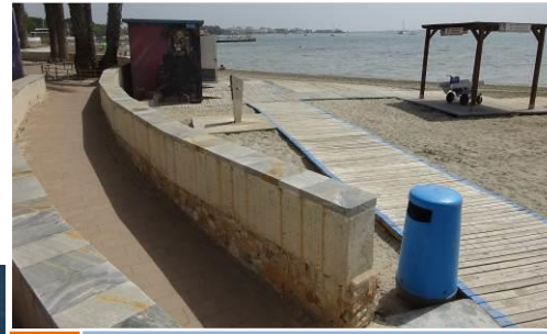
6 Rampa de acceso
