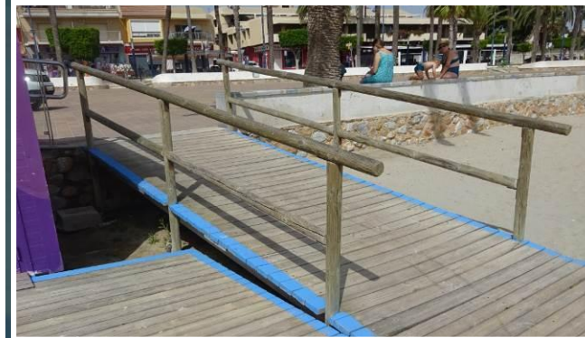
5 Rampa de acceso
