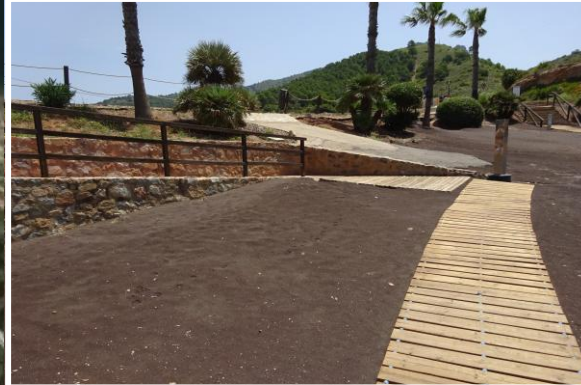
3 Rampa de acceso
