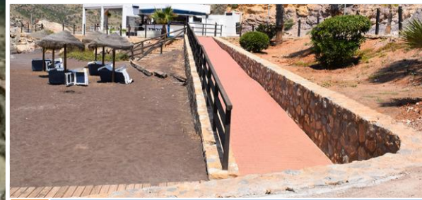
4 Rampa de acceso
