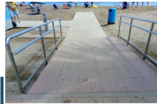
3 Rampa de acceso y pasarela
